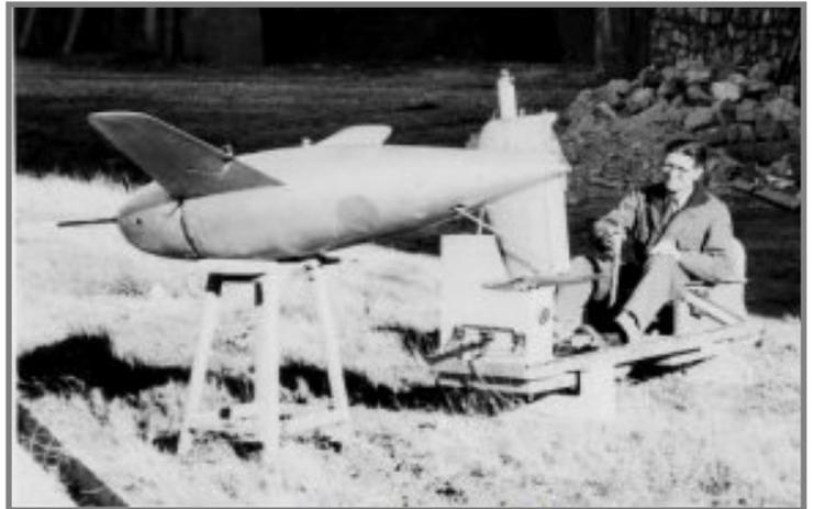
**Essais du pilotage des commandes de la bombe ( 160 kg) par son concepteur**
