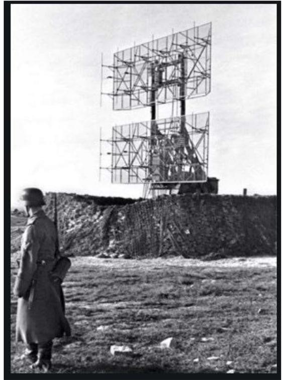
A partir d'août 1942 fut mis en service le "**Würzburg Reise**". Dérivé de l'ancien "Würzburg" de conduite de tir de la Flack, il allait constituer l'élément principal du système allemand de contrôle de la chasse. Ce radar de poursuite avait une portée de 80 kilomètres ; en plus de l'azimut et de la distance il pouvait déterminer l'altitude. Il était armé par trois opérateurs installés dans une cabine solidaire de l'antenne parabolique orientable manuellement sur 360°.
